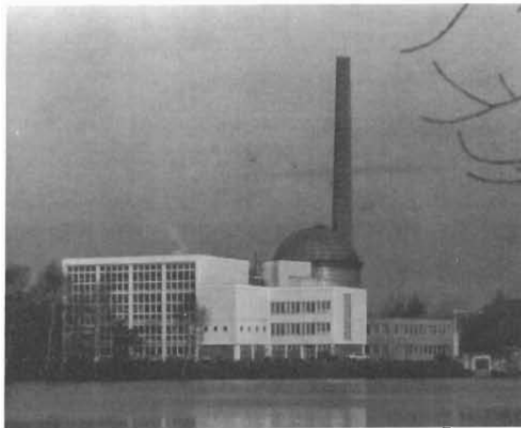
図. 1 BR - 3 原子力発電所の全景
