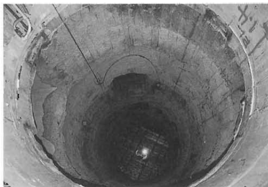
写真1 放射線遮蔽体内面 制御爆破作業終了の状況
