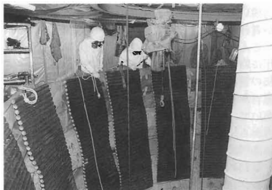
写真2 制御爆破作業準備 (防爆フェンス設置状況)
