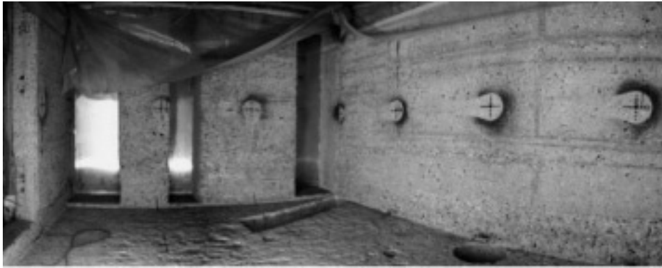
図3 原子炉建物内の部屋の除染後の状況 1)
