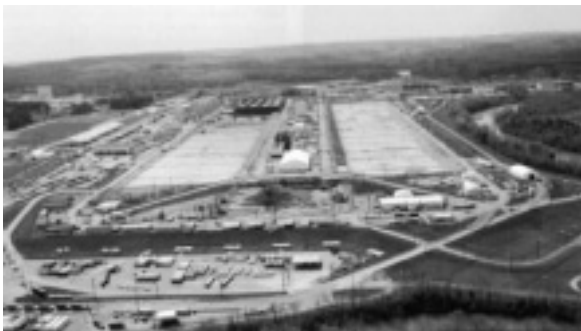
図2 残っている東ウィングの一部
